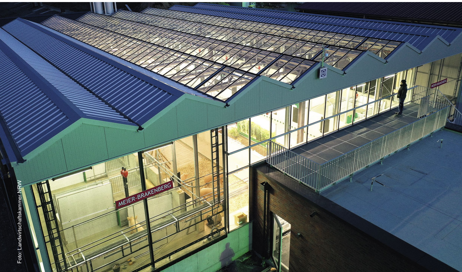
△ Die Besucherplattform ermöglicht jederzeit einen Einblick in das gesamte Stallsystem 2.
