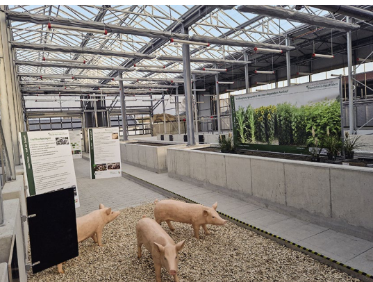
△ Die Glasplatten auf dem Dach in der Mitte des innovativen Stalls lassen sich öffnen.
